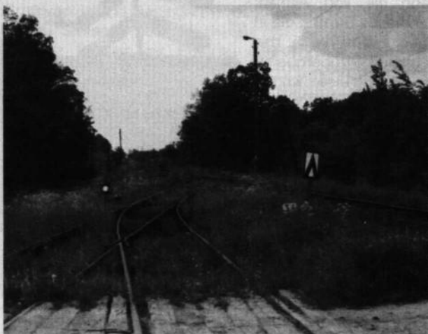
Gleisanlage im Grünen, Fahrtrichtung: Troop-Iggeln-Marienburg
